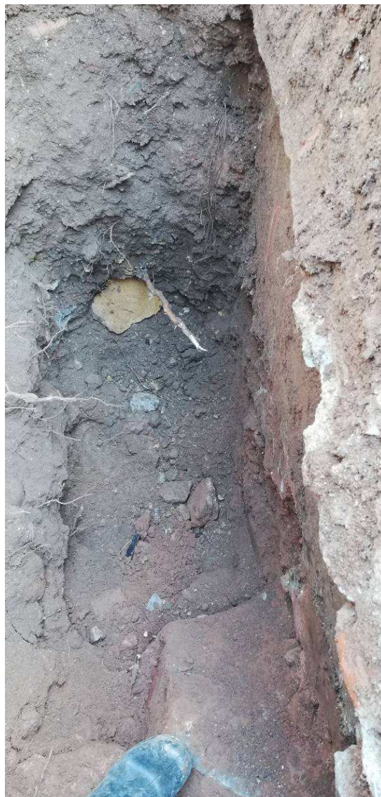
Patrný přechod betonového pasu v místě přechodu rekonstruované a původní zdi.
