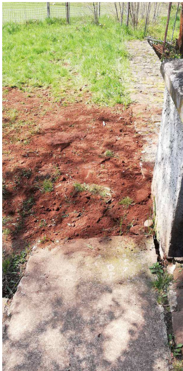
Zasyp sondy s urovnáním a navrácením do původního stavu.
